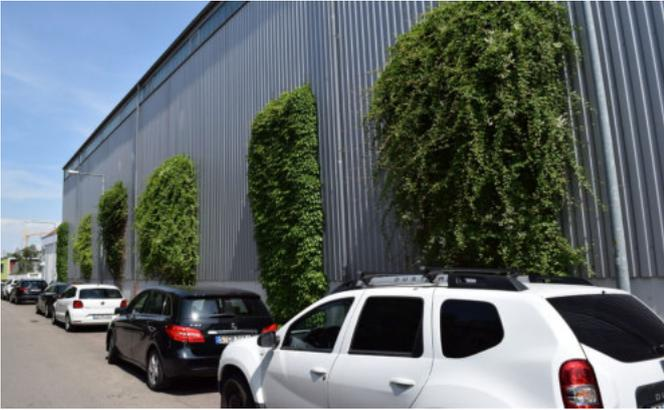
**Abb. 60** Beispiel aus Stuttgart: an einer mit Trapezblech verkleideten Hallenwand wurde eine bodengebundene Fassadenbegrünung mit Kletterhilfen installiert. (BuGG)
