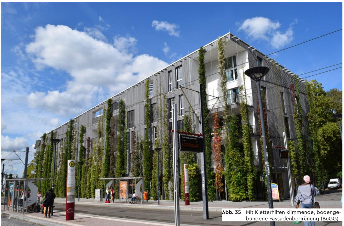
**Abb. 35** Mit Kletterhilfen klimmende, bodengebundene Fassadenbegrünung (BuGG)
