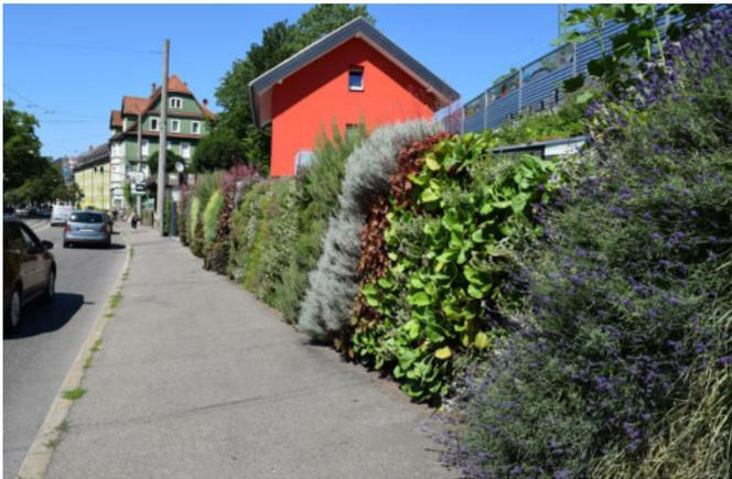
**Abb. 38** Wandgebundene Fassadenbegrünung mit Modulen (BuGG)
