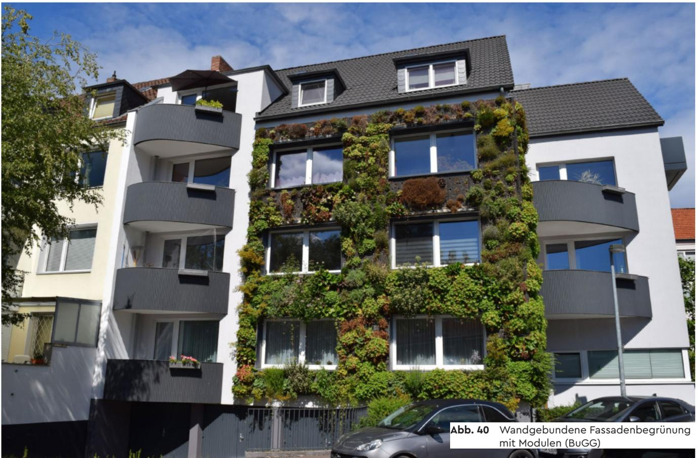
**Abb. 40** Wandgebundene Fassadenbegrünung mit Modulen (BuGG)
