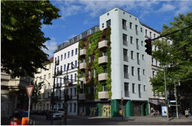
**Abb. 37** Wandgebundene Fassadenbegrünung mit Vlies (BuGG)
