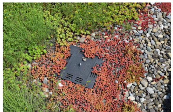
Abb. 29 Überwachener Kontrollschacht (BuGG)
