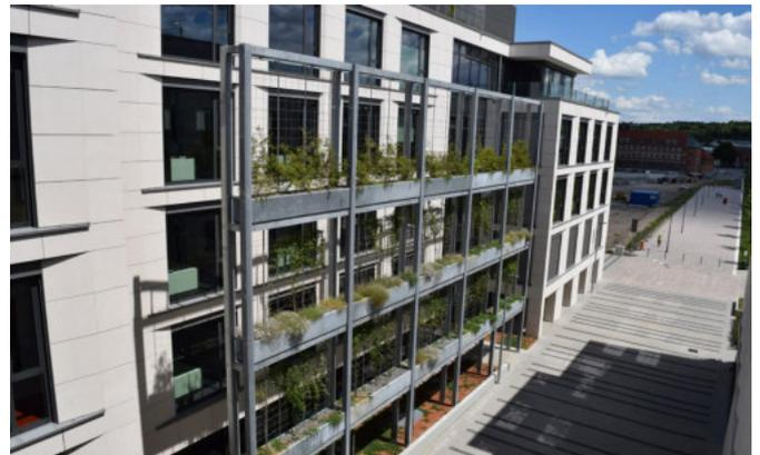
**Abb. 67** Wandgebundene Fassadenbegrünung in „Regalbauweise“ aus Stuttgart, bei dem die Konstruktion selbsttragend bzw. lastabtragend in den Boden ohne Fassadenkontakt steht. (BuGG)
