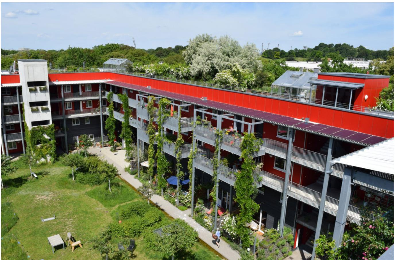
Abb. 59 Dach- und Fassadenbegrünung an einem Wohngebäude (BuGG)
