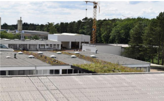
**Abb. 62** Nachträgliche extensive Dachbegrünung bei der Fa. Reckhaus in Bielefeld: „Streifenförmige“ Begrünung, vermutlich über einer Stützmauer. (BuGG)
