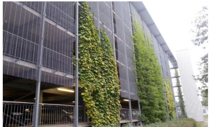
**Abb. 65** Messeparkhaus München, wo Kletterhilfen in Form von Gittern installiert wurden, um die bodengebundene Fassadenbegrünung zu führen. (BuGG)
